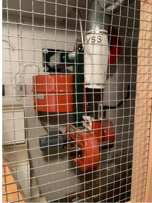
Väestönsuojan IV-laite
